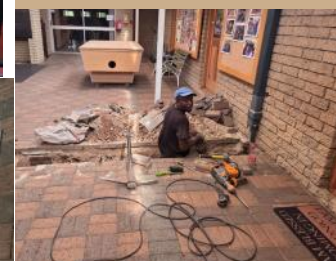
Die afvoerpype in die binnehof is vergroot om die water beter weg te lei. Die tuin rondom die boom is nuut aangeplant en uitgelê onder tannie Rentia se leiding.
